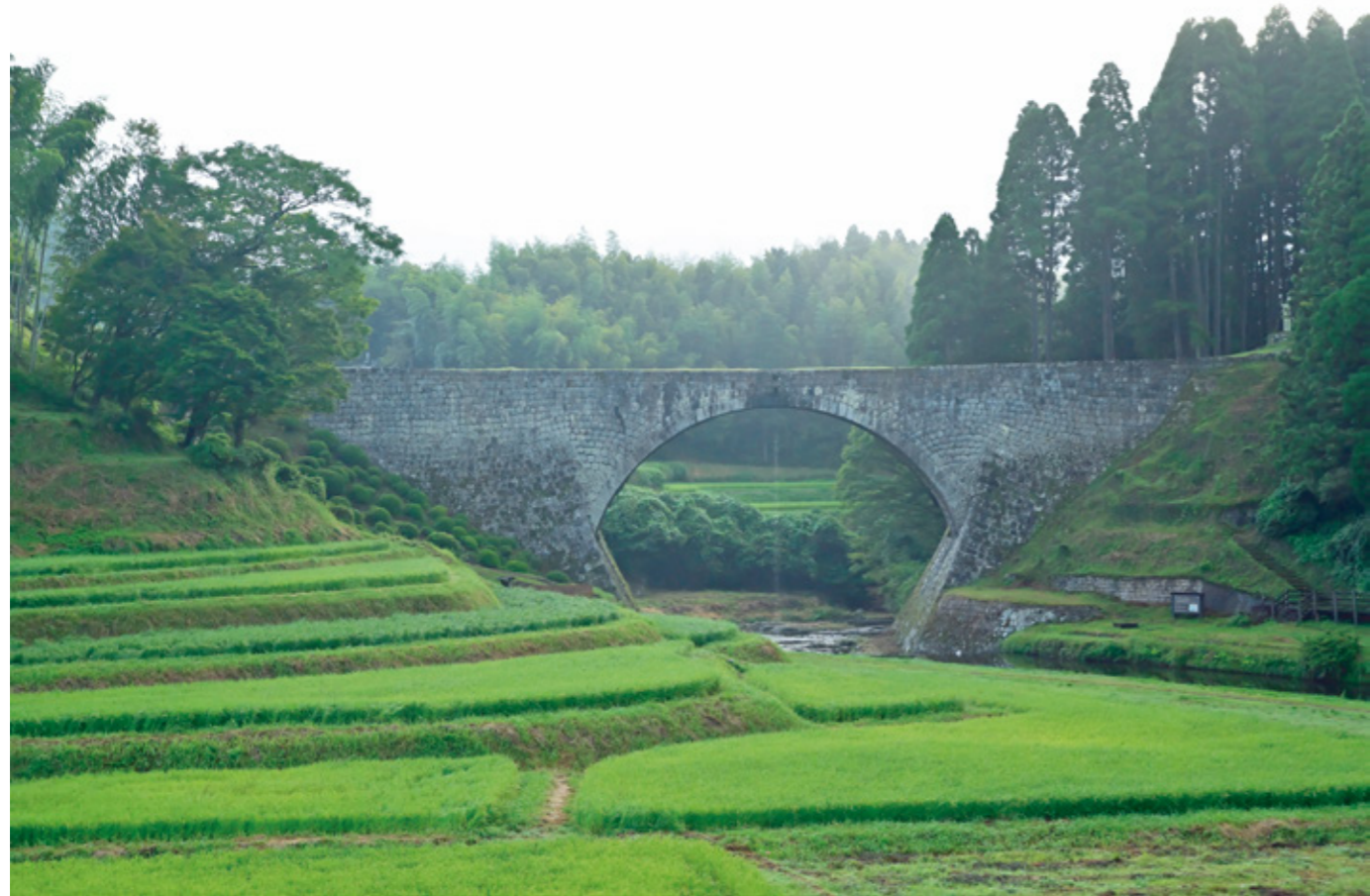
通潤橋 〒861-3661 熊本県上益城郡山都町長原 【時間 / 定休日】 特になし（見学自由） 【利用料金】 無料 / 8月27日を除く放水日の午前10時から午後3時までは橋上観覧（有料）ができます。 【駐車場】 大型：18台、小型：136台（無料） 【備考】 ■建築年 / 1854年 ■長さ / 約78.0m 幅 / 約6.6m 高さ / 約21.3m
